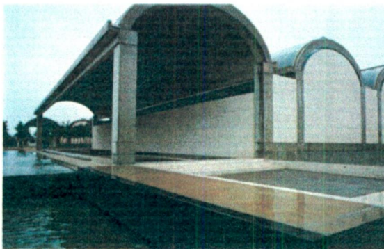
エントランス・ポーチ部 Entrance portico
