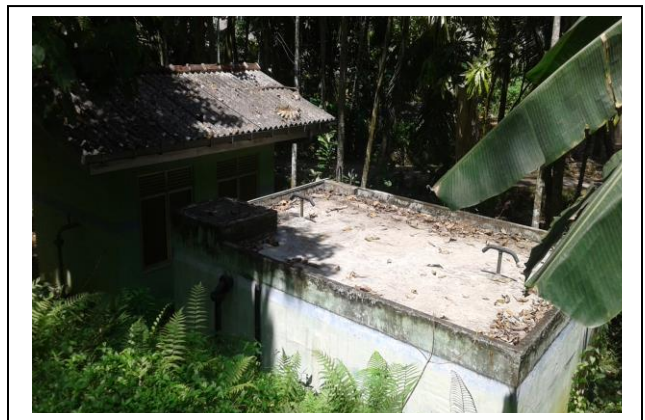
(Image: 4.2.1.2 GodadeniKanda Ground Sump)
